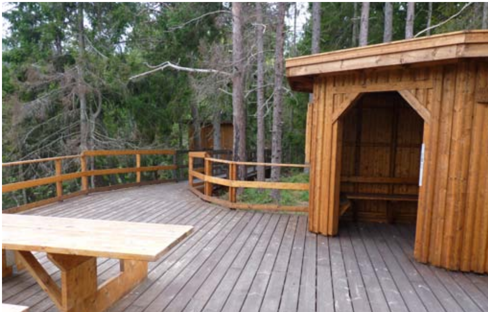
Tillgängligt vind- och regnskydd i Smitingens naturreservat, Väster- norrlands län. Vindskyddet står på ett plant trädäck utan tröskel och har en bred öppning. Det finns gott om svängutrymme i och utanför skyddet. Se även avsnitt 14.3. Foto: John Granbo
