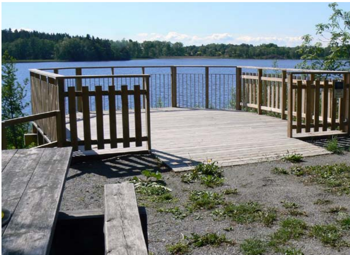
I Hamra nationalpark, Gävleborgs län, finns skyddsnet på den utsiktsplattform som ger utblick över Svansjön. Skyddsnetet ger bra genomsikt och god säkerhet. Se även avsnitt 14.2. Foto: Tomas Ärlemo
