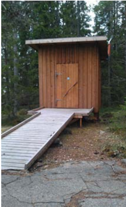
Tillgängligt dass i naturreservatet Rotsidan, Västernorrlands län. Dörren är bred och har ett bra handtag. Rampen har avåkningskydd och vändplanen framför ingången är väldimensionerad. Foto: Erika Hedhammar
