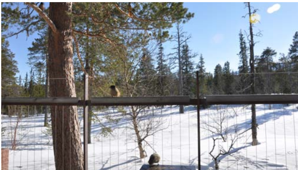
Räcket i Fulufjällets nationalpark, Dalarnas län, är ett bra exempel på ett säkert räcke som saknar den övre tvärslå som lätt hamnar i ögonhöjd för sittande eller kortväxta personer. Foto: Sofia Tiger
