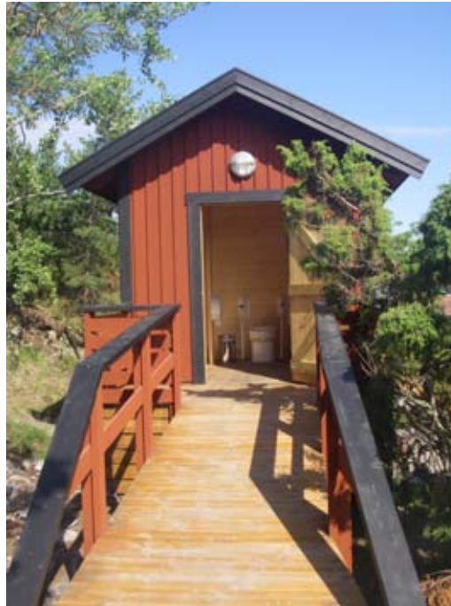
Toalettbyggnad med ramp och räcken i naturreservatet Nåttarö, Stockholms län. Svängutrymmet utanför och inne på toaletten är vältilltaget och toalettstolen är försedd med nedfällbara armstöd på båda sidor. Foto: Kersti Wiberg
