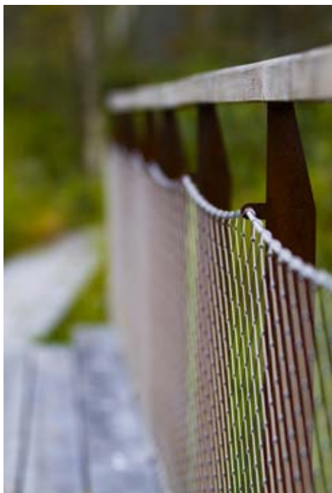
I Hamra nationalpark, Gävleborgs län, finns skyddsnet på den utsiktsplattform som ger utblick över Svansjön. Skyddsnetet ger bra genomsikt och god säkerhet. Se även avsnitt 14.2. Foto: Tomas Ärlemo
