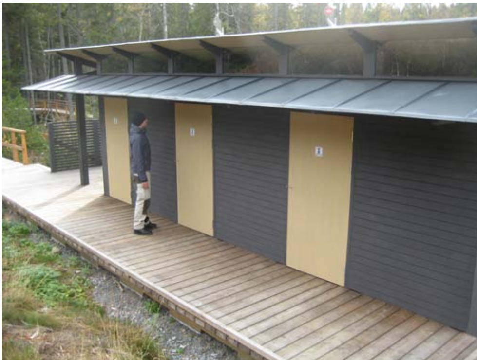
Till toaletten i Skuleskogens nationalpark, i Västernorrlands län, kan man ta sig via trappor eller ramp. Dörröppningarna är breda och saknar tröskel. Toalettbyggnaden är lätt att nå både från parkeringen och från entrén. Foto: Camilla Näsström
