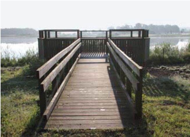
Utsiktsplattform för bland annat fågelskådning vid våtmarken Gäddängen i Fulltofta naturreservat, Skåne län. Den nedre delen av skyddsräcket medger ingen genomsikt men det fria utrymmet över spjalorna ligger på cirka 0,85-1,25 meter och möjliggör därmed sikt för vuxna personer som sitter i rullstol och för de flesta barn. Plattformen har också ett stödbord som man kan använda sig av vid fågelspänning sittandes i rullstol (syns dock inte på bilden). Foto: Eva Tronarp
