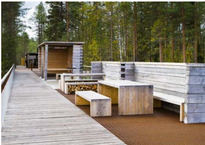
Plattform med skyddsräcken på ett underlag av trä, betongplattor och järngaller. På plattformen finns grill, information och sittmöjligheter, även under tak. Borden på bilden saknar utskjutande bordskiva vilket gör det svårt att sitta vid dem med rullstol. Foto: Tomas Årlemo
