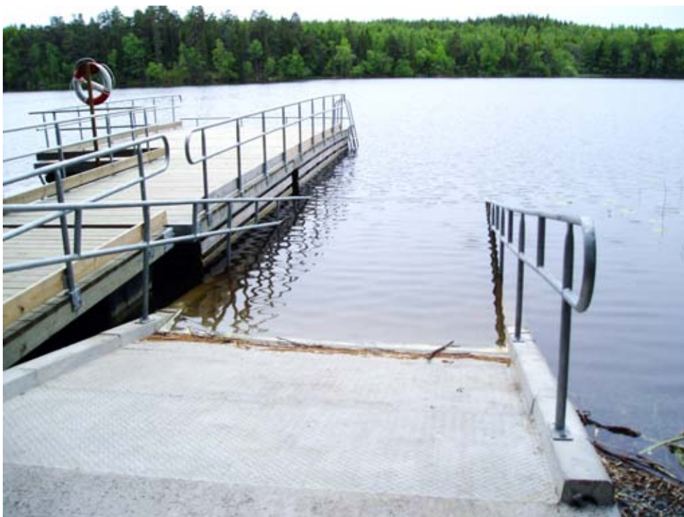
Brygga och badramp med avåkningskydd/ledstråk och räcken i Fjällnora fri-luftsområde, Uppsala län. Rampen på bilden är dock något för brant och räcken sitter för långt isär för att man ska kunna hålla i sig med båda händerna. Foto: Camilla Wessberg
